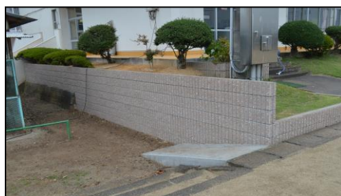
南舎西側の崩れかけた斜面を修理していただきました。
